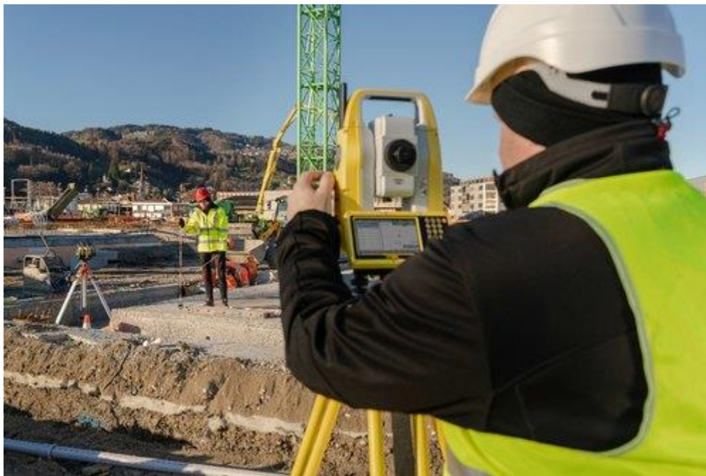
Nu met gebruik van een Total station
